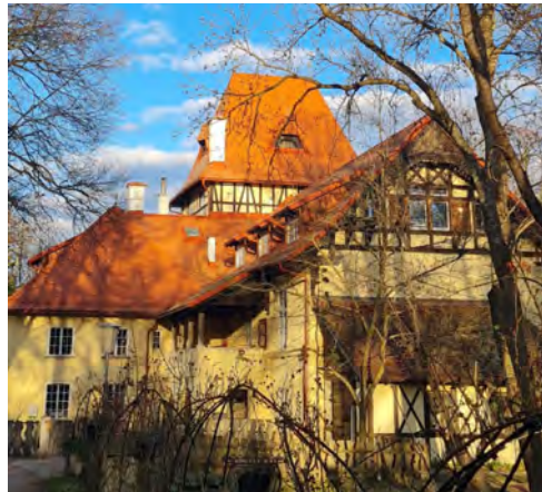
Im Mittelpunkt der Betrachtungen: Das Kastell. Es laufen alle nötigen Arbeiten auf Hochtouren, um dieses doch sehr umfassende Projekt sauber in Gang zu setzen. Das Schulzeitungsteam wünscht allen Beteiligten viel Erfolg.
